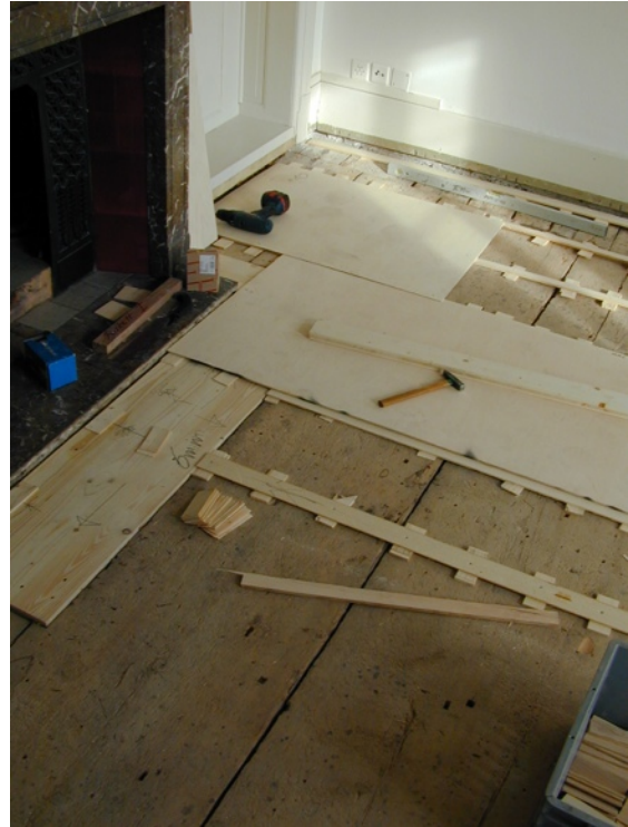
Abb. Nr. 6 Blindbodenbretter stumpf gestossen mit einer Breite von bis zu 74 cm. Vorbereitung der reversiblen vollflächigen Schiftung aus Birkensperholz
