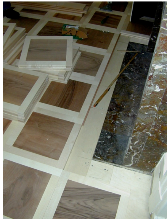
Abb. 7 Einpassen der neuen Tafelparketttafeln. Sie weisen eine Bauteilstärke von 35 mm auf.
