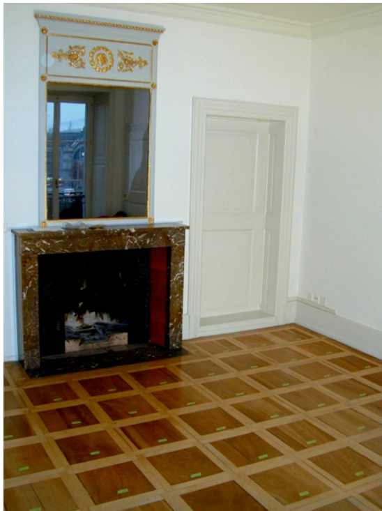
Abb.1 Vorzustand Salon mit Tafelparkett Nussbaum und umgebendes Ahornfries
