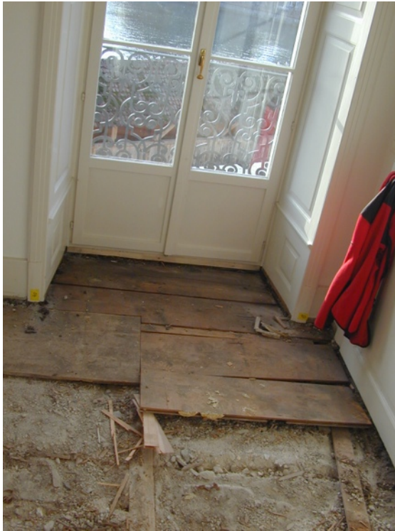
Abb.5 Entfernen von nicht mehr tragfähigen Blindbodenbrettern
