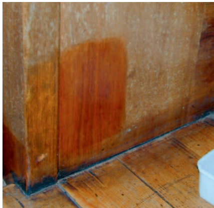
Abb. 8b: Darstellung der Bauteiloberfläche mit einer weißlichen-splinterigen Oberflächenbeschichtung (Celluloselack). Industrieller Lackauftrag. Am unteren Bildrand ist eine Muster-Probefläche als Konservierungsvorschlag dargestellt.
