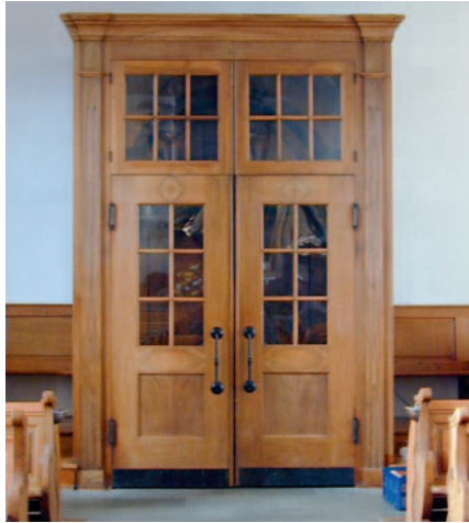
Abb. 8a: Darstellung einer Windfangverkleidung in einer Kirche von 1935.
