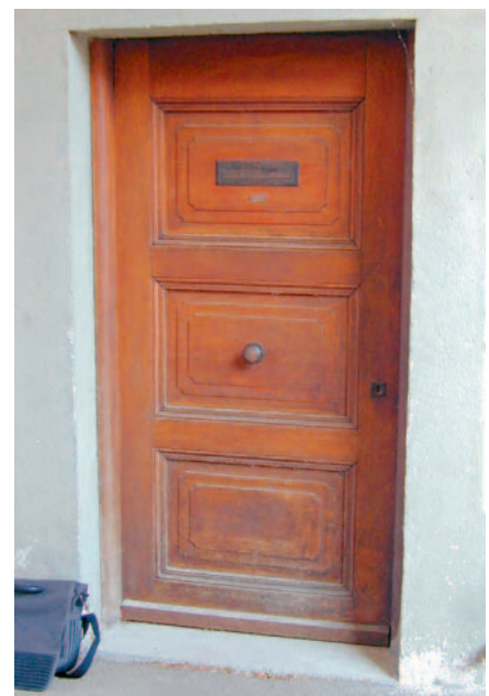
Abb. 4a: Darstellung einer Eingangstüre von 1926 in Eichenholz gearbeitet. Der Bindemitteltypus der Oberflächenbeschichtung ist ein Ölharzlack.
