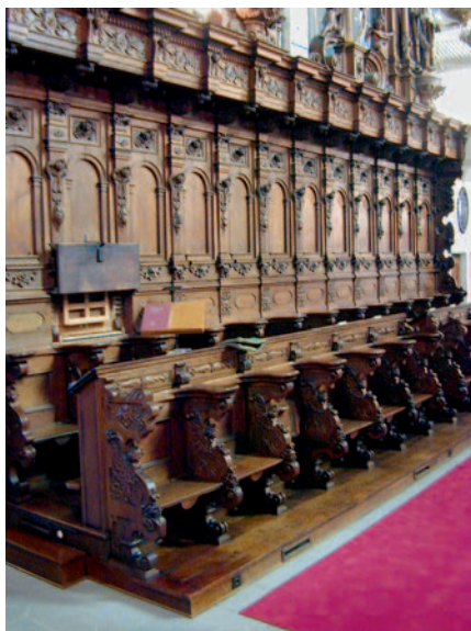
Abb. 5a: Darstellung eines Chorgestühls um 1640 mit einem Ölharzlack (Leinöl mit Bernstein verkocht).
