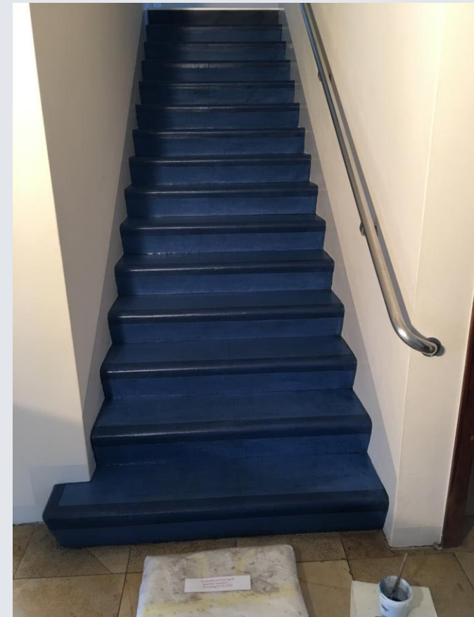
Abb. 1 Ansicht Treppentritte Vorzustand / Abb. 2 Treppenpodest in Verbindungsgang mit Kamptulikonbelag mit Marmorierung Vorzustand / Abb. 3 Endzustand nach erfolgter Konservierung(Foto Peter Egloff 2019)
