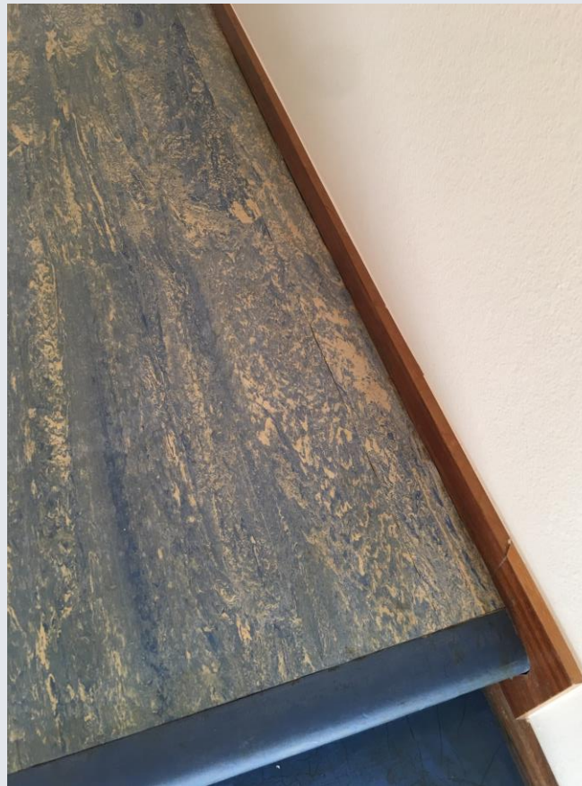
Abb. 1 Ansicht Treppentritte Vorzustand / Abb. 2 Treppenpodest in Verbindungsgang mit Kamptulikonbelag mit Marmorierung Vorzustand / Abb. 3 Endzustand nach erfolgter Konservierung(Foto Peter Egloff 2019)
